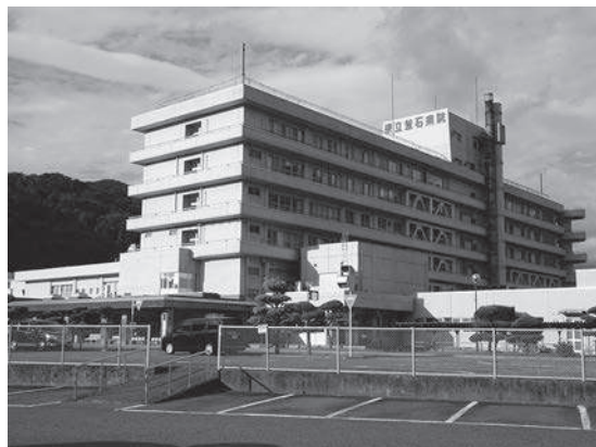
5年以内に整備着工される県立釜石病院
