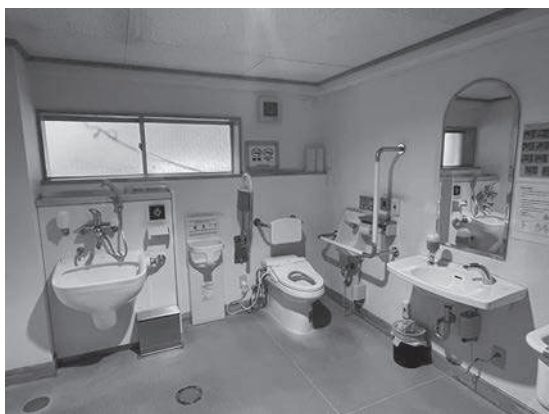
市役所本庁舎1階の多目的トイレ
