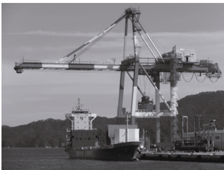
釜石港設置のガントリークレーン
