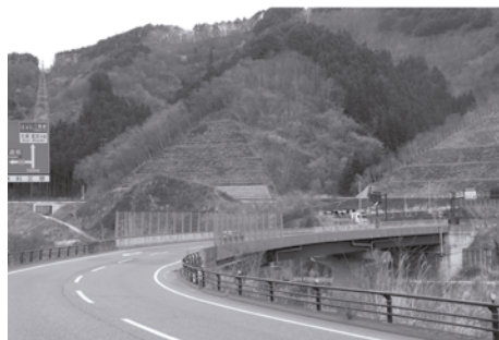
釜石両石インターチェンジ
