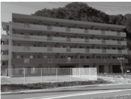
復興公営住宅（両石町）
