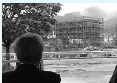
上平田川 水門工事
