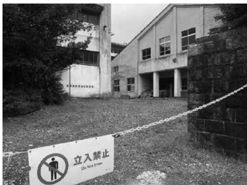
解体予定の校舎 効率的な土地利用とは
