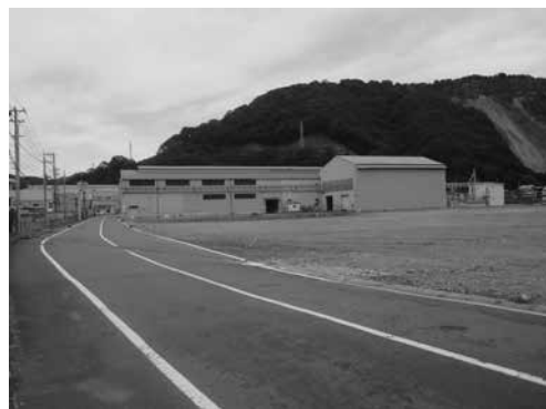
新工場建設予定地
