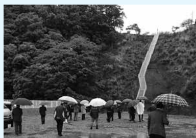
大字平田 避難階段整備工事
