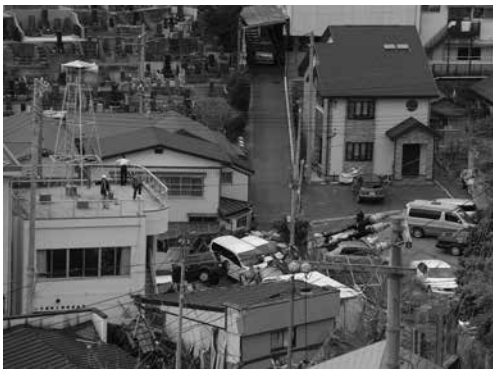
震災復旧から漏れた“市道”周辺
