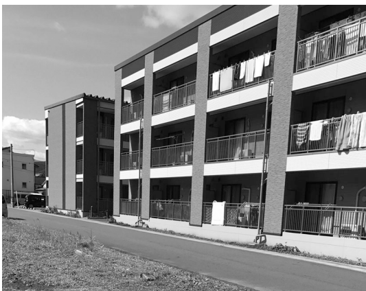
復興公営住宅
