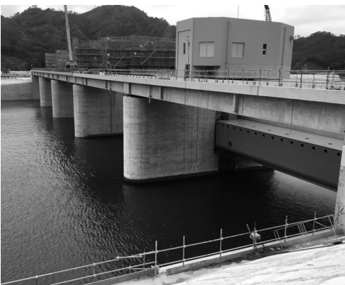
完成間近の鵜住居川水門
