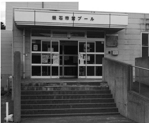
釜石市営プール
