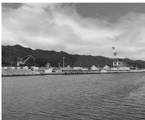
釜石港・ガントリークレーン
