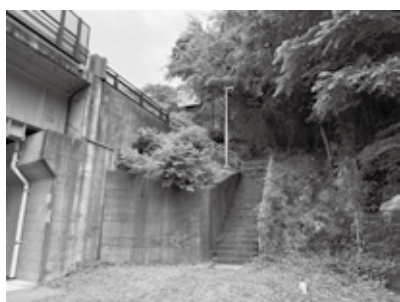
嬉石漁港近くの避難道入口
