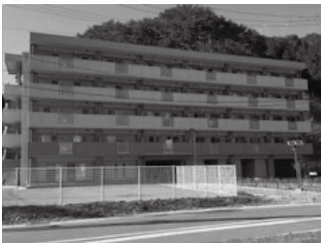
復興公営住宅（両石町）
