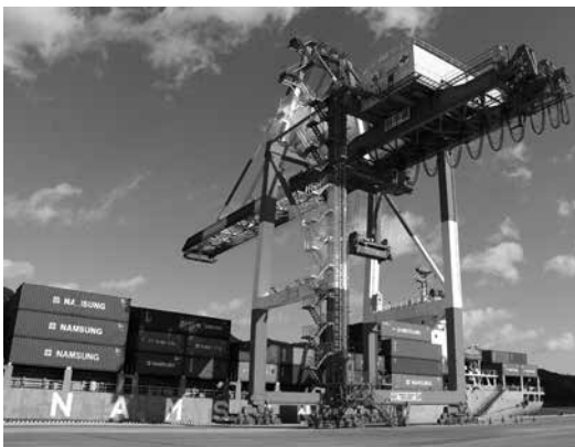
荷役中のガントリークレーン
