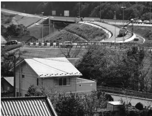
建設中の復興道路
