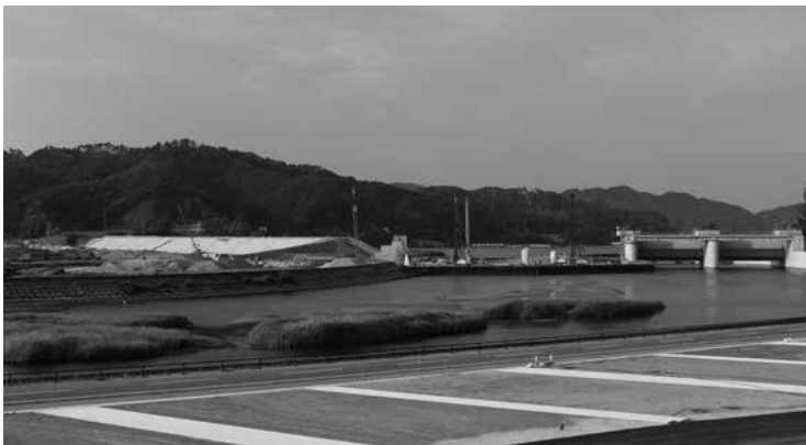
鶴住居復興スタジアム(仮称)から望む防潮堤
