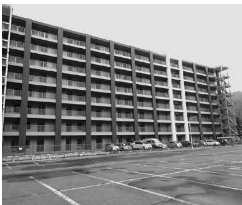
復興公営住宅（上中島町）
