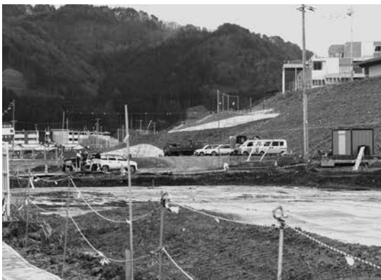
嵩上げ中の鷺住居地区学校施設前
