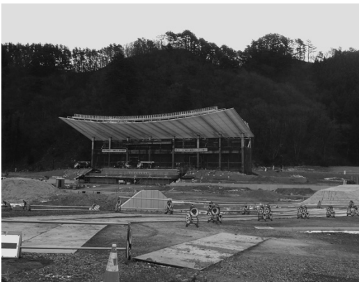
建設中の釜石鵜住居復興スタジアム（仮称）
