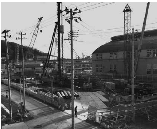
建設中の汐立雨水ポンプ場
