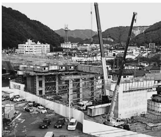
建設中の三陸沿岸道路
