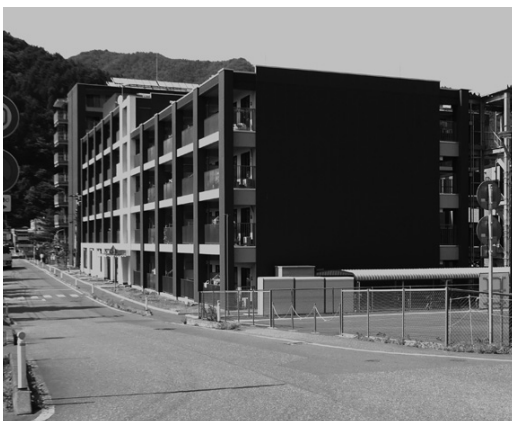
復興公営住宅（上中島町）
