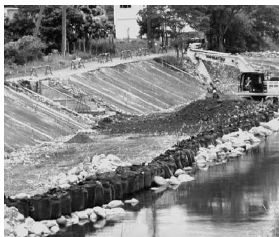
甲子川松倉橋上流の護岸工事
