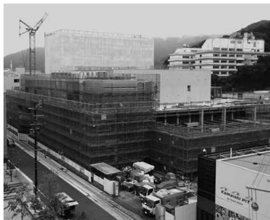
建設が進む釜石市民ホール（仮称）
