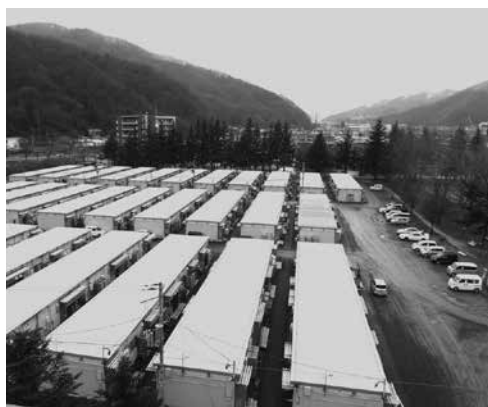
上中島町仮設団地
