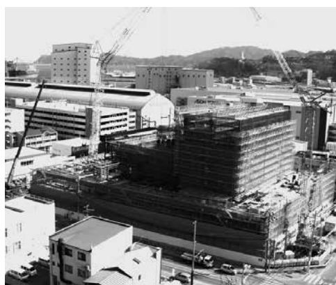
建設中の釜石市民ホール
