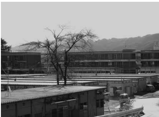
仮設住宅と復興公営住宅（天神町）
