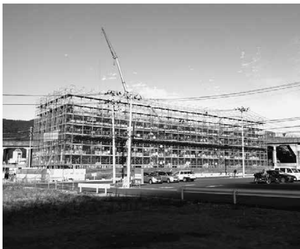
建設中の復興公営住宅（松原町）
