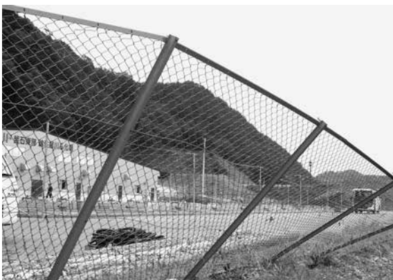
台風10号で被害を受けたふ化場施設 (釜石東部漁業協同組合：鶴住居町)
