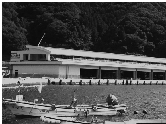
建設中の新釜石魚市場
