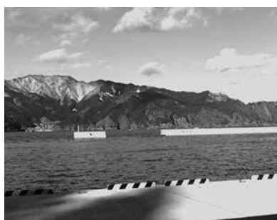
大石東防波堤の被災箇所
