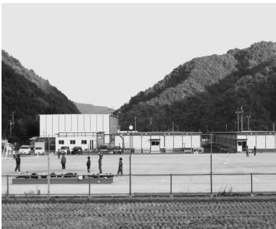
鵜住居小学校・釜石東中学校仮設校舎
