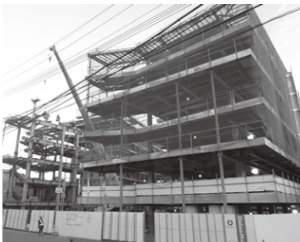
建設中の復興公営住宅（大町）
