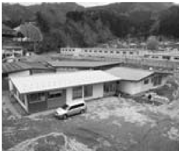
建設中の認定こども園（天神町）
