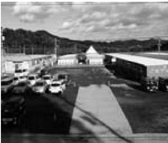
平田第6仮設団地
