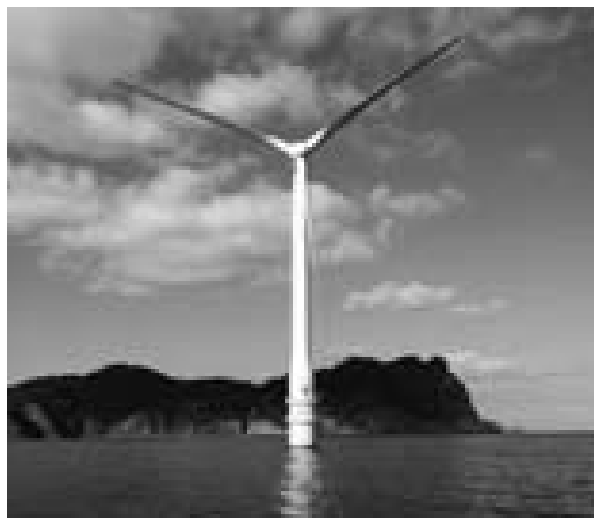
浮体式洋上風力発電実証事業 実証機（五島市杵島沖） 全長172m、翼直径80m。
