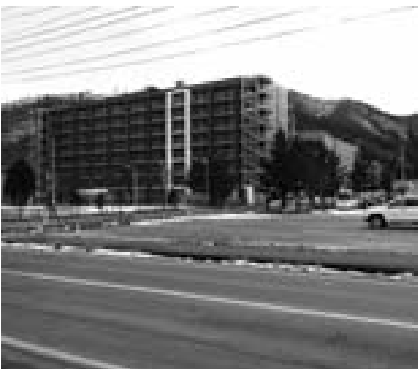
建設中の復興公営住宅（上中島町）
