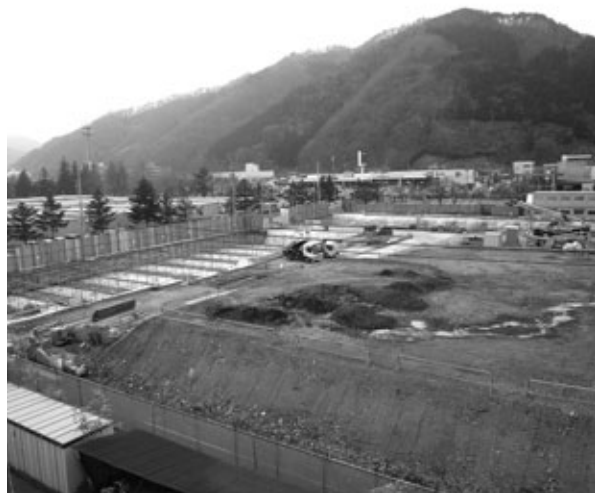
基礎工事が進む上中島復興住宅第Ⅱ期
