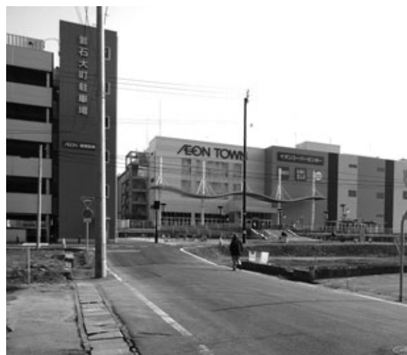
釜石まちづくり株式会社が管理を行う釜石大町駐車場
