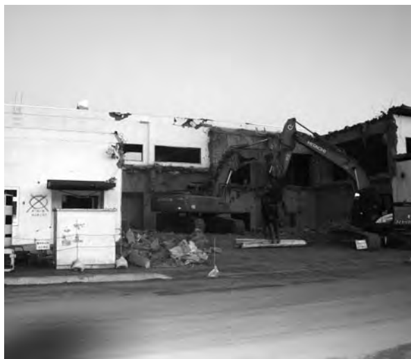
解体中の鵜住居地区防災センター
