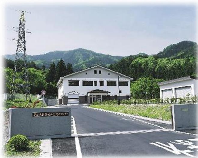
釜石・大槌汚泥再生処理センター
