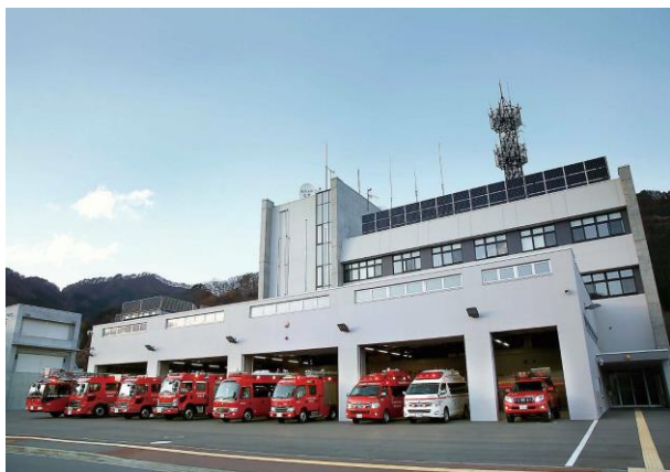
釜石消防庁舎
