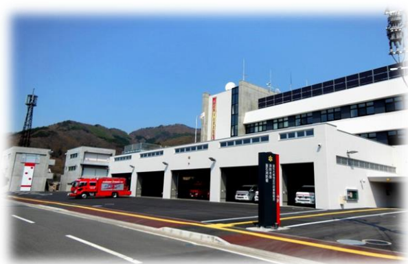
釜石消防庁舎
