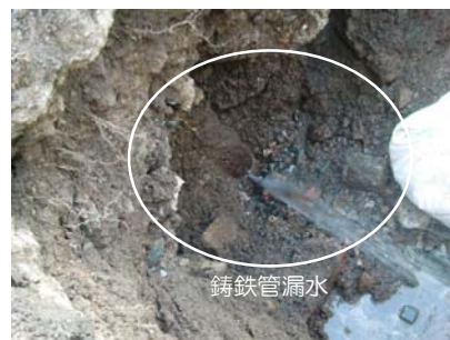
铸铁管漏水状況
