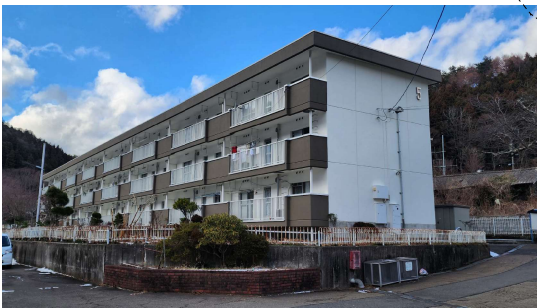
令和7年度 外部改修後写真（5号棟）
