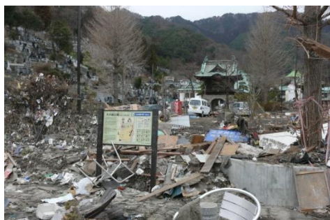
石応禅寺前の被害（大只越町1丁目）
