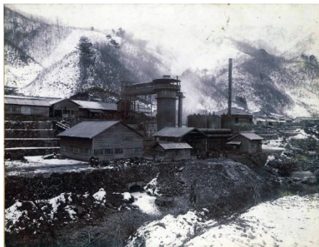
稼働中の栗橋分工場
