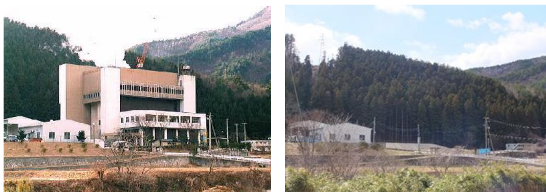
図 3.28 釜石市清掃工場の解体前と解体後
