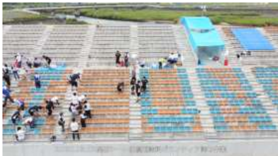
スタジアム木製シートの防腐剤塗布作業の様子
