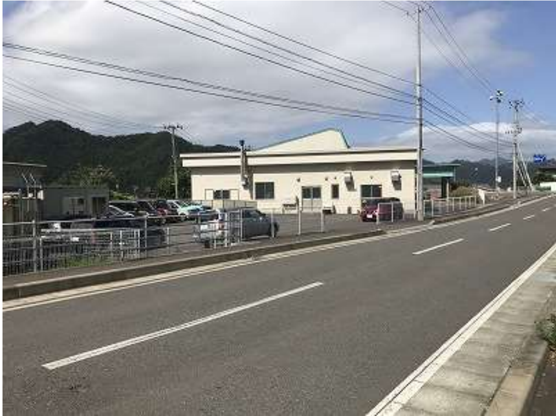
【整備後の状況】
