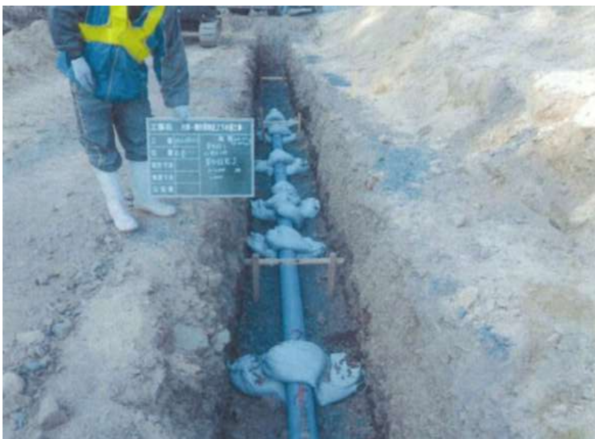
【管路布設完了写真】
