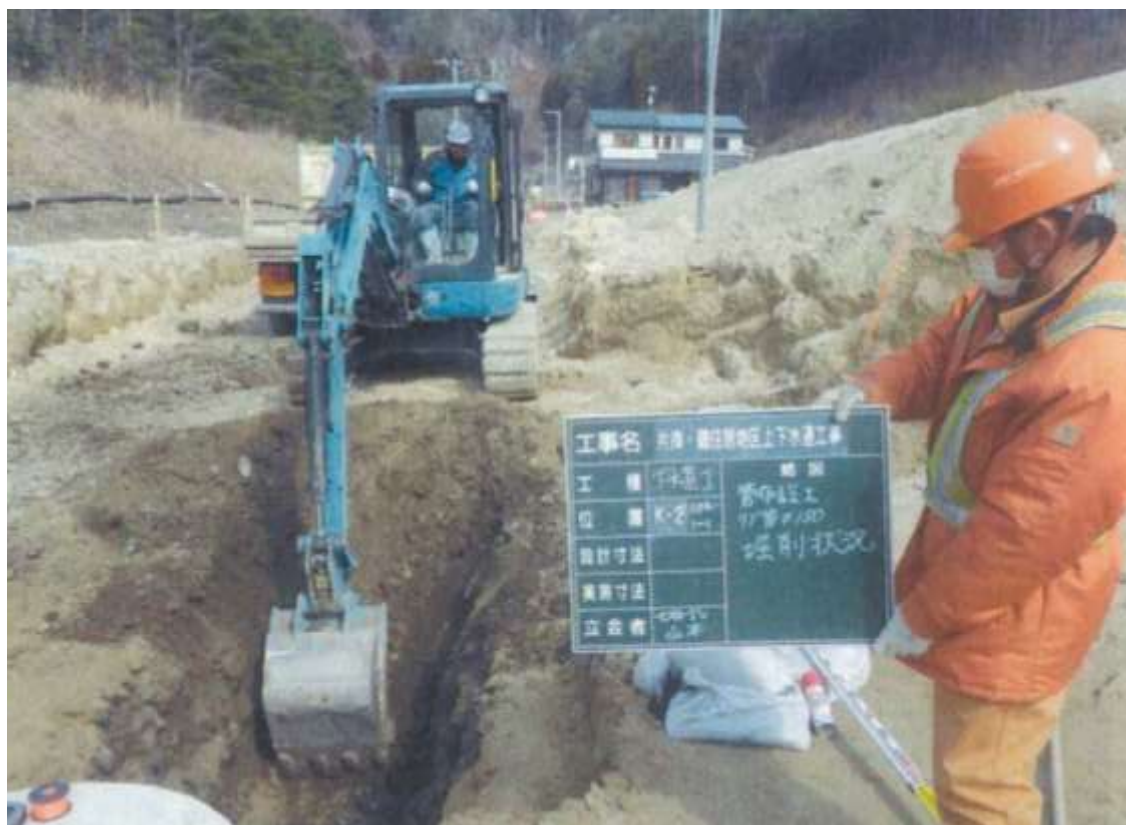
【管路布設前写真】
