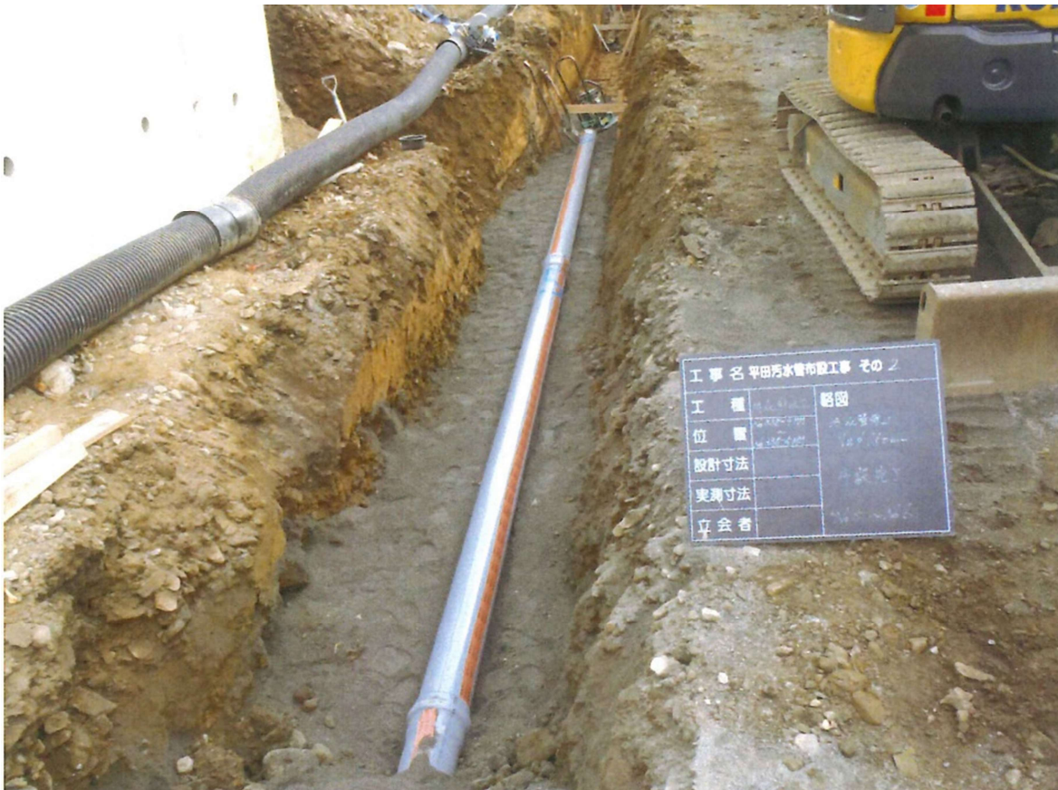
【管路布設完了写真】
