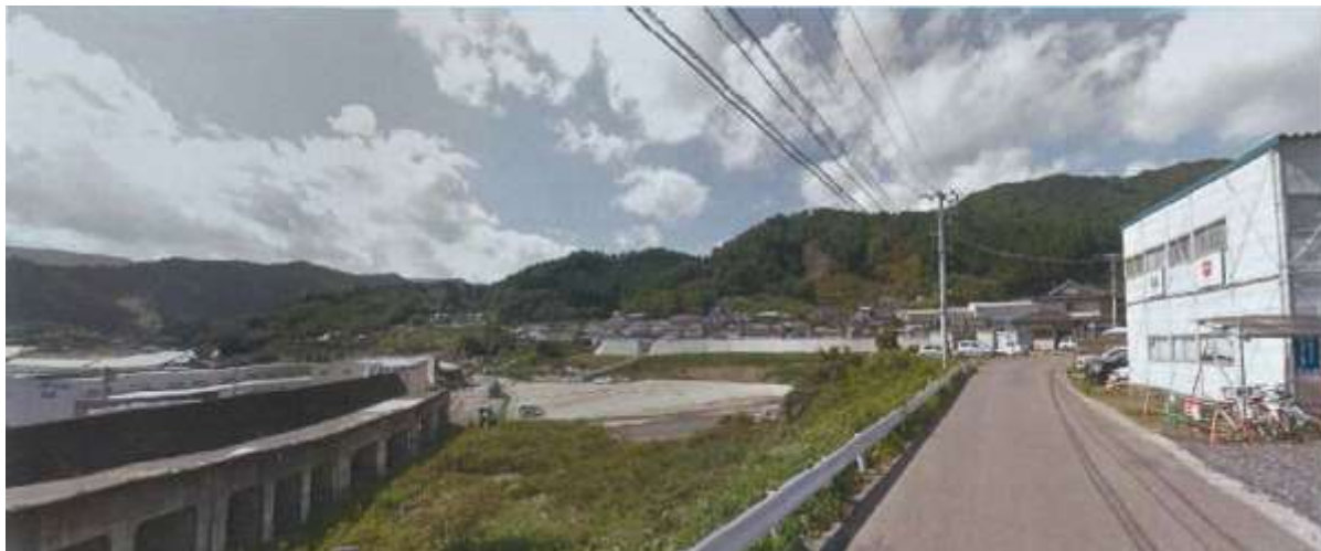
【移転元の被災状況】（小白浜地区）
