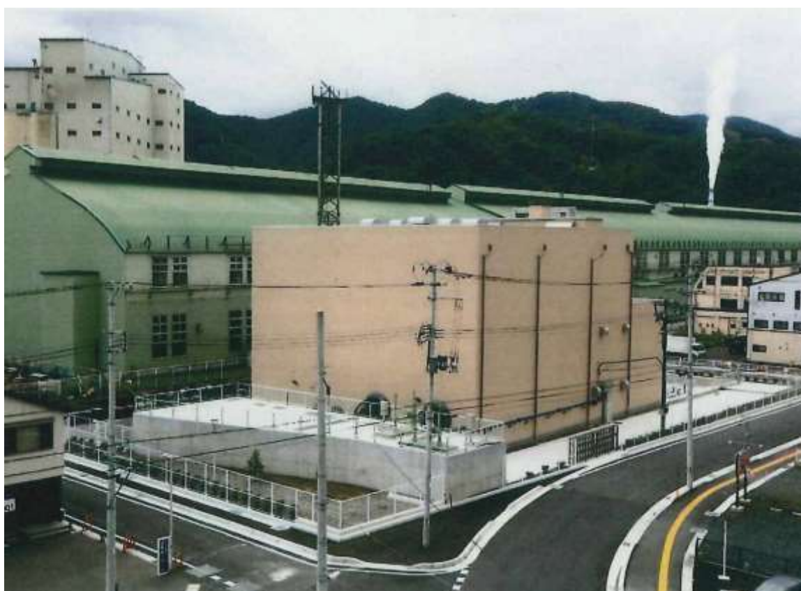
【完了写真】（汐立雨水ポンプ場）
