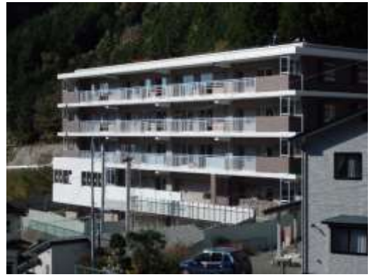
主要内部（居間）
