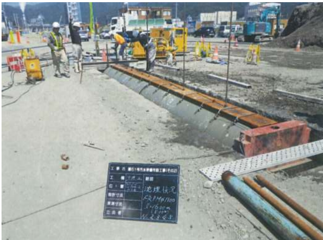
【管路布設完了写真】
