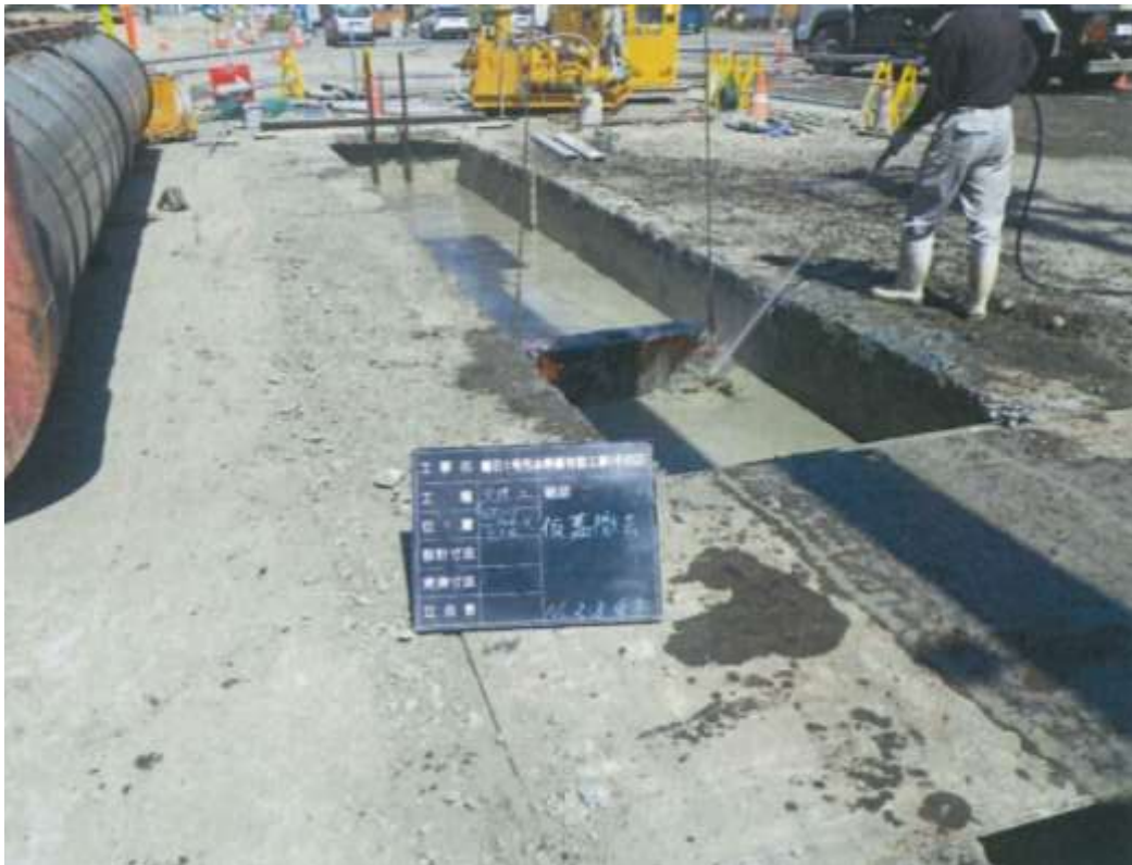
【管路布設前写真】
