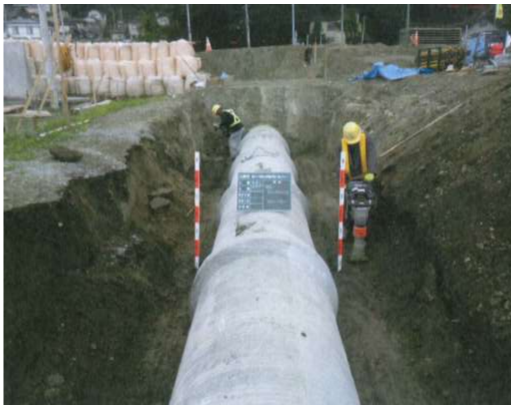
【管路布設完了写真】
