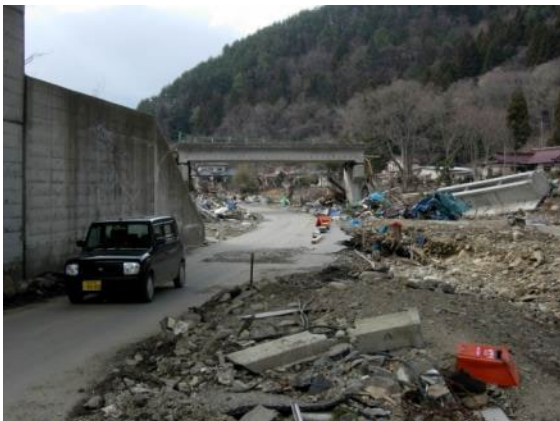
【整備前の旧県道の被災状況】
