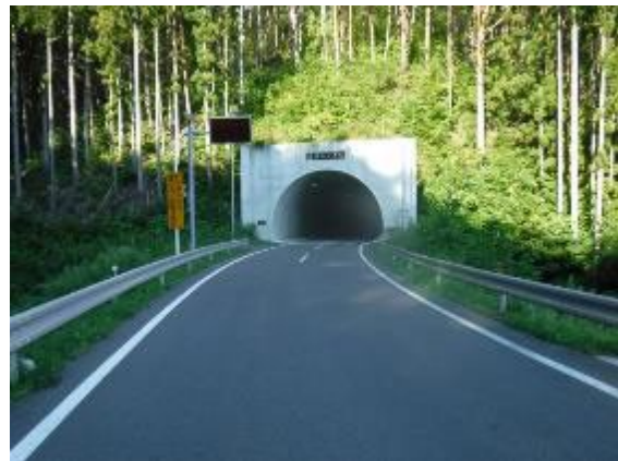
【整備後の新県道の状況】
