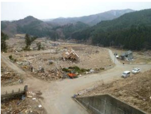
【整備前の旧県道の被災状況】
