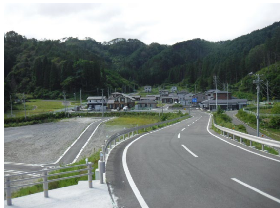
【整備後の新県道の状況】
