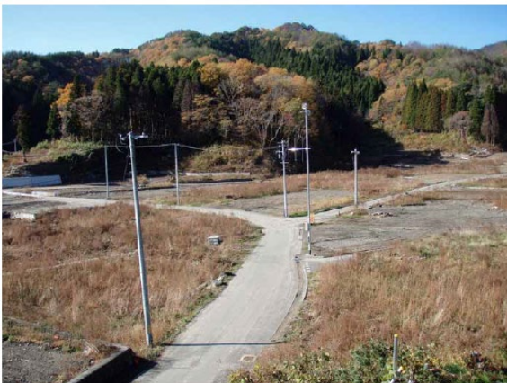
【整備前の旧県道の被災状況】
