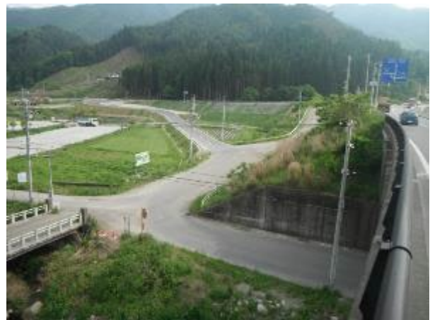
【整備後の新県道の状況】
