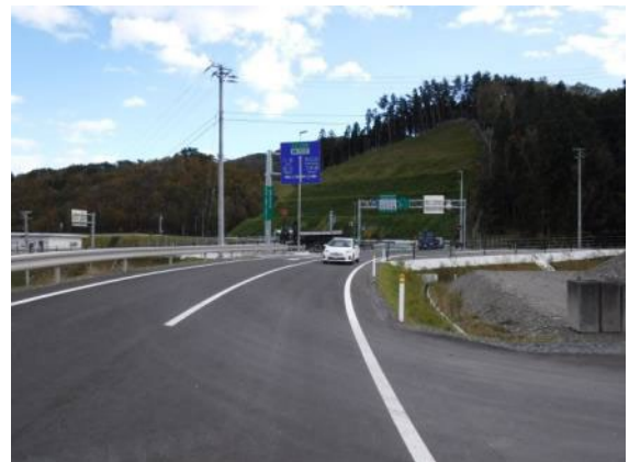
【整備後の新県道の状況】
