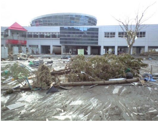
【被災状況（外観）】
