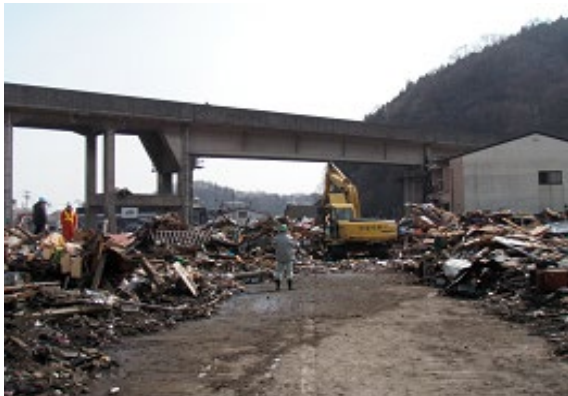
【整備前の旧国道の被災状況】
