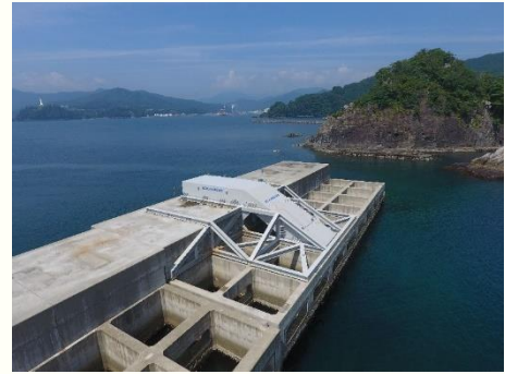
出典：(株)マリンエナジーホームページ 釜石湾口防波堤の波力発電装置
