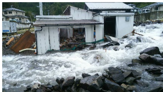
2019年台風19号による被害の様子
