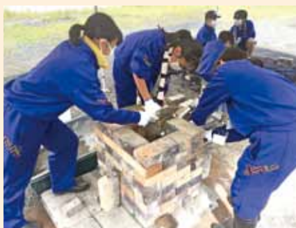
協力して炉を組み上げます
