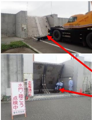
に実施されました。重機により引上げ、開閉の動作確認等の所定の点検を行い、正常な稼働を確認しました。津波の来襲時には地域の防災・減災に十二分に効果を発揮することが期待されます。
