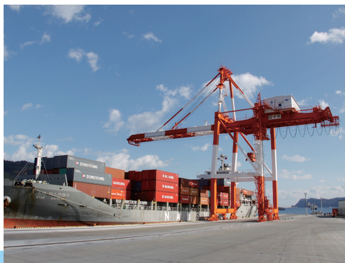
ガントリークレーン(釜石港公共ふ頭)
