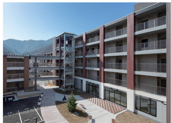
上中島復興公営住宅
