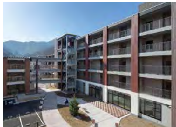
上中島復興公営住宅
