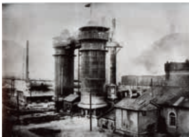
第1、第2高炉（25トン高炉）
