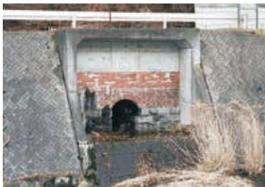
小川アーチ橋梁1号橋
