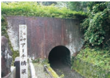
小川アーチ橋梁2号橋
