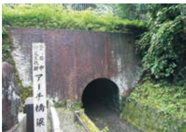
小川アーチ橋梁 2号橋
