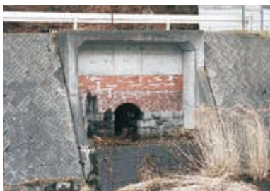
小川アーチ橋梁 1号橋
