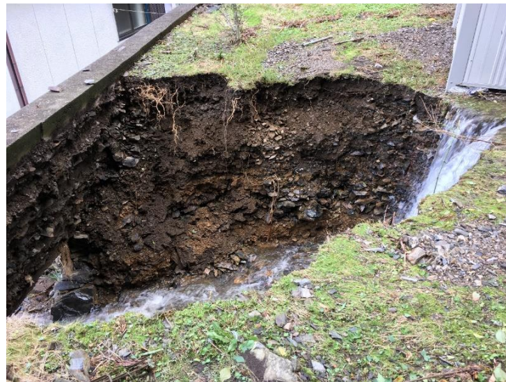
⑫ 東前町土留め壁損傷状況
