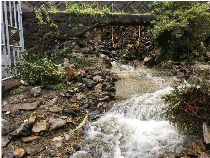
⑪ 東前町土留め壁損傷状況
