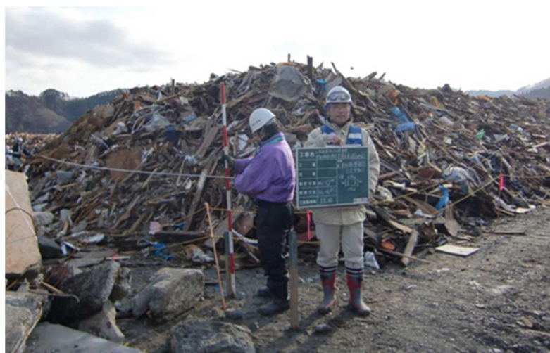
仮置場の出来形計測の様子
