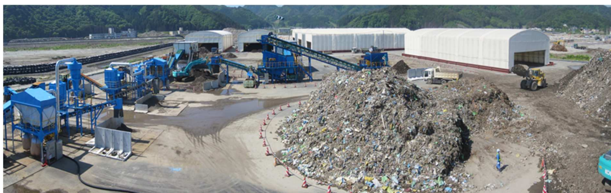
【参考】東日本大震災災害廃棄物処理事業 片岸仮置場（中間処理プラント）の様子
