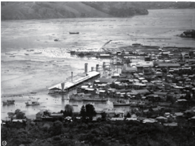
チリ地震による津波被害 / Tsunami damage from the Chile earthquake
