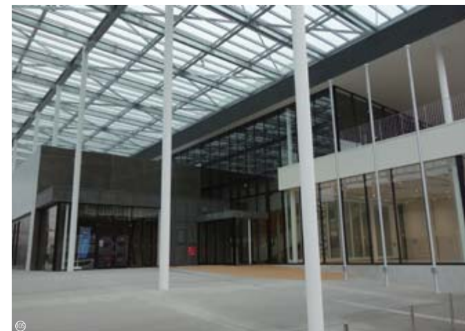
釜石市民ホール TETTO The "TETTO" Kamaishi Citizens' Hall
