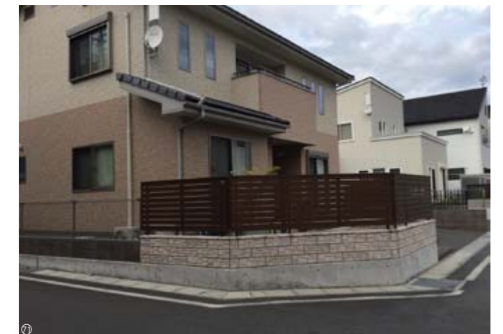
⑦ 部分的嵩上げによる自力再建 / Self-help reconstruction by partial elevation
