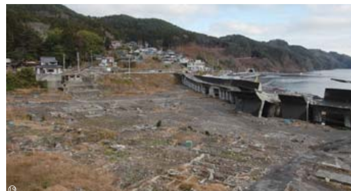
倒壊した唐丹湾防潮堤 / Collapsed seawall along Toni bay
