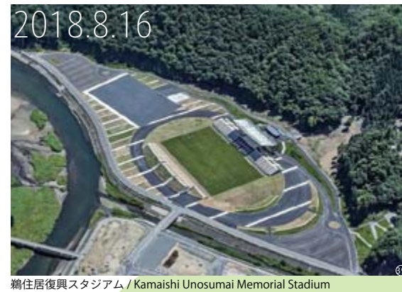
鶴住居復興スタジアム / Kamaishi Unosumai Memorial Stadium
