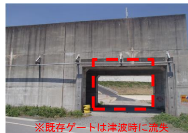
陸閘①スライドゲート: (W6.0m × H4.7m)
