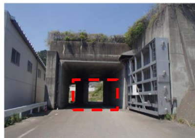
陸閘②片開きゲート: (W3.5m × H3.0m)
