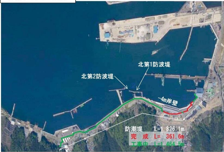
復旧後 (平成29年5月19日撮影)
