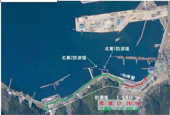
復旧後 (平成29年5月19日撮影)
