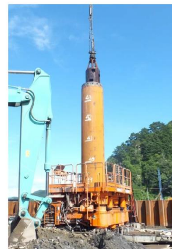
先行掘削置換え工 (オールケーシング工法) φ1000~φ1200
