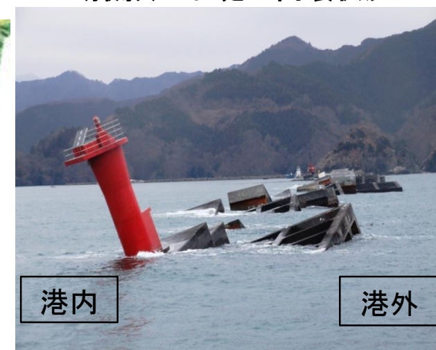
(撮影) 北堤の倒壊状況
