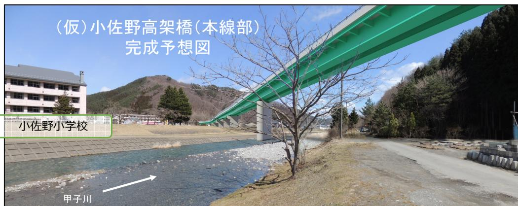
(仮)小佐野高架橋は、橋長460.7メートルの本線部分と釜石中央インターチェンジ(仮称)へ降りる橋長117.7メートルの支線部分に分かれた橋です。本線部分は甲子川と小川川をまたぎ、支線部分は小川川をまたぎます。橋を架ける工事は、平成29年7月下旬から始まっています。
